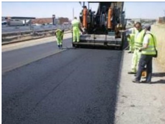
Foto 2: Aplicación en capa intermedia. Termografía de mezcla a salida de regla
